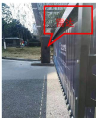
图 3 道闸雷达安装效果图
