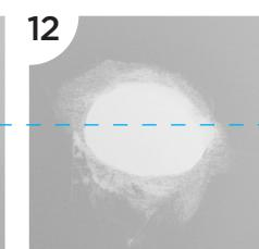
Use el raspador para sobrellenar apenas la zona dañada con el compuesto para reparar paredes. El sobre llenado permite lijar la reparación una vez seca y lograr una superficie lisa.
